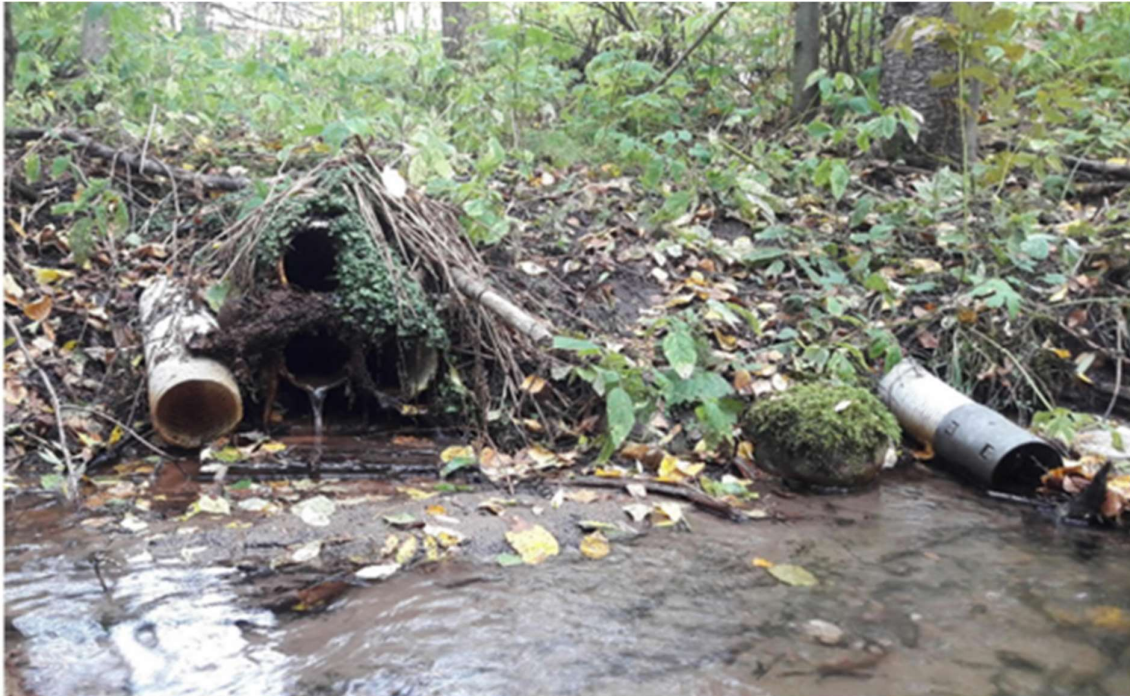
Kuva 25. Tervaleppäkorven puron alajuoksulla havaittiin useita pieniä hulevesiputkia kasattuna päällekkäin ja vesi valui niistä suoraan uomaan.
